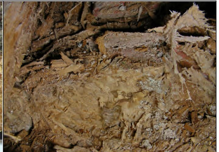
Abb. 29: Bohrmehl des Gescheckten Nagekäfers: Kotpartikel sind typisch diskus- oder linsenförmig; oberhalb des Bohrganges liegt eine sehr dünne Holzschicht, die intakt ist; Maßstab mit Millimetern.
