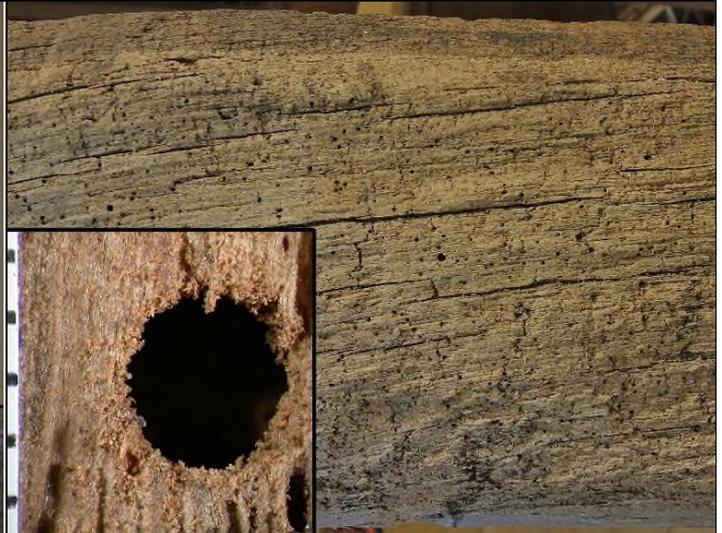
Abb. 45: Zugstrebe aus Eiche des historischen Dachstuhls mit einer oberflächlichen Fäule (mutmaßlich Moderfäule) aus einer Zeit mit massiven Dachschäden, zudem Schäden durch Gescheckten und Gewöhnlichen Nagekäfer (*Anobium punctatum*); Eckbild: fast rundes Ausschlußpfloch; Maßstab mit Millimetern.
