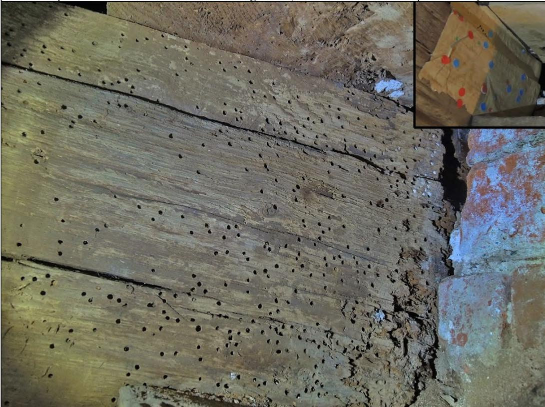
Abb. 61: Ein typischer, für das Monitoring ausgewählter Balkenkopf. Es liegen zahlreiche Ausschlupflöcher des Gescheckten Nagekäfers vor; ihre Anzahl ist an der Wand am größten und nimmt mit der Entfernung zur Wand ab; in gleicher Weise nimmt der Fäuleschaden ab; Eckbild: markierte Ausschlupflöcher.
