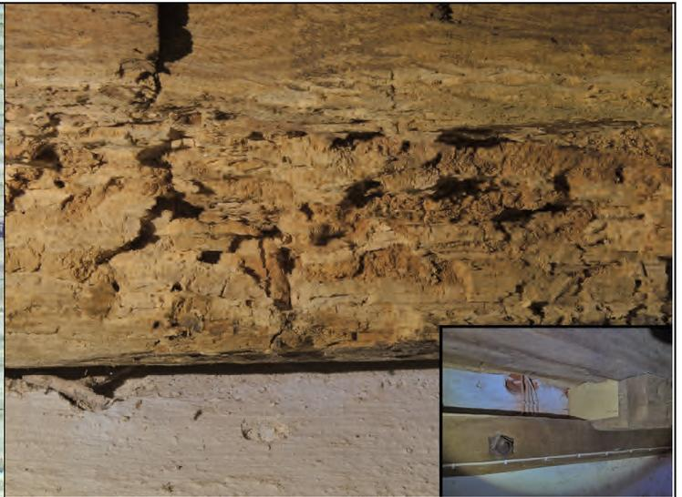
Abb. 26: Typischer Kombinationsschaden an einem Streichbalken aus Eiche: Weißfäule-Schaden auf der Wandseite mit Ausschlußflöchern des Gescheckten Nagekäfers.
