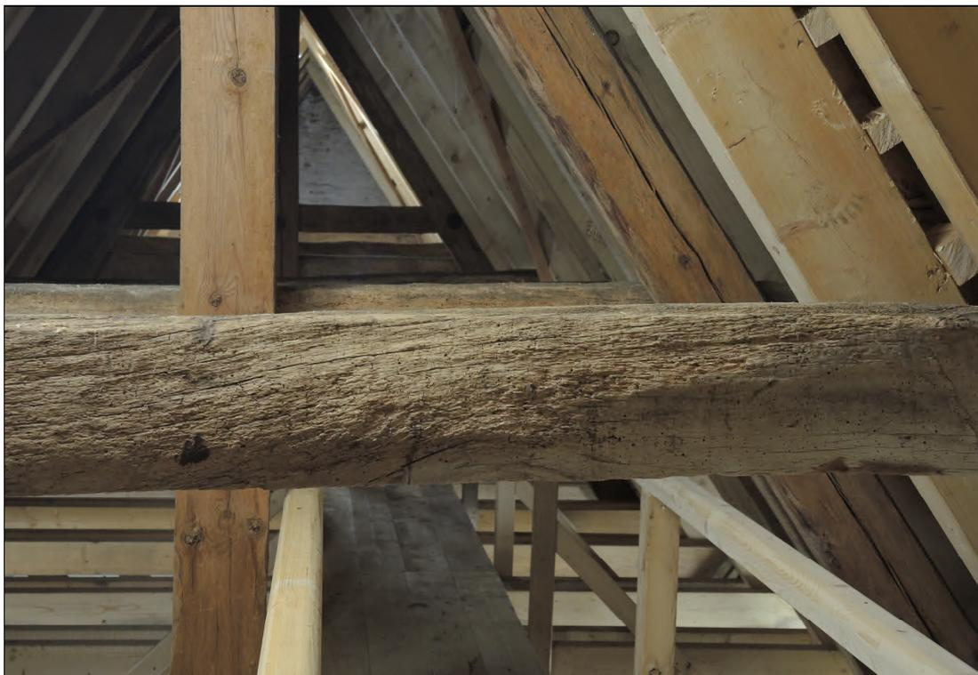
Abb. 68: Der historische Dachstuhl im Firstbereich nach der Sanierung; ein zweiter Dachstuhl wurde in den ersten eingefügt; alte Balken blieben erhalten; Vordergrund: Balken mit erloschenem Befall durch den Gewöhnlichen Nagekäfer (*Anobium punctatum*); befallen sind die Splintholzbereiche.
