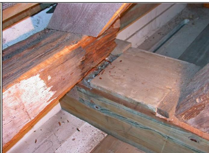
Abb. 76: Norddeutsche Kirche bei Hamburg: Sofortiger Neubefall nach einer Sanierung aufgrund einer mangelhaft angebrachten Folienebene, die Niederschlagswasser an den Balken führte. Es entstand ein lokaler Schaden durch einen Braunfäule-Erreger. Der neue Deckenbalken war chemisch geschützt.
