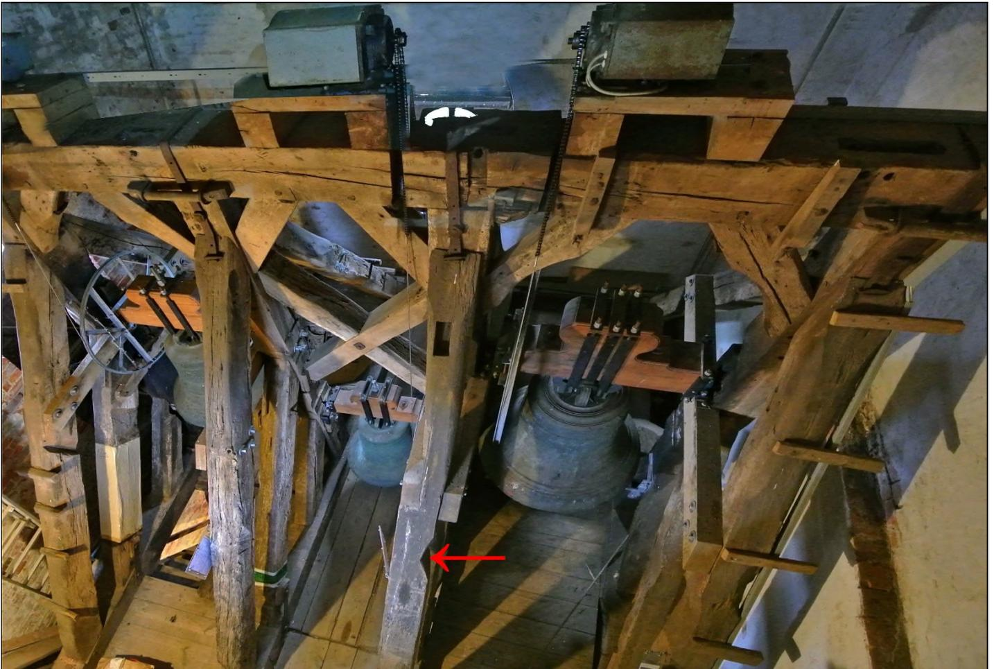
Abb. 77: Historischer Glockenstuhl mit Lebendbefall durch Gescheckten Nagekäfer an einigen Balken. Für die große Glocke wurde ca. 1955 am Glockenstuhl Aussparungen vorgenommen, hier wurden Fraßgänge angeschnitten (Pfeil); am Glockenstuhl sind zahlreiche Umformungen sichtbar, die in den Jahrhunderten nötig wurden; zuletzt wurden neue Joche eingefügt; Blick nach Norden.
