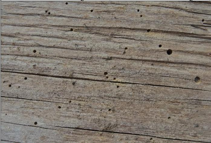
Abb. 10: Doppelbefall: Insekten und Pilz; Übergang zwischen den Schäden durch Gescheckten und Gemeinen Nagekäfer, also zwischen Trockenholz- und Feuchtholzinsekten. Status in der Kirche: Gemeiner Nagekäfer abgestorben; Gescheckter Nagekäfer: lebend.
