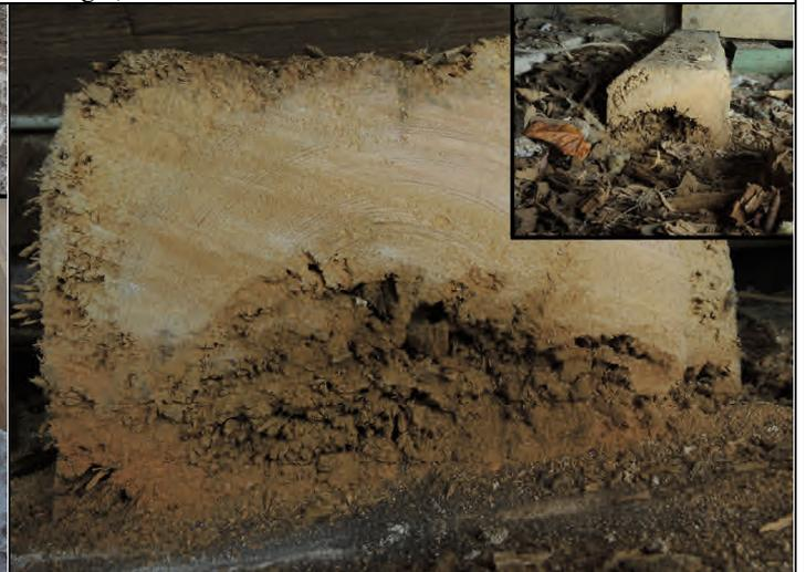
Abb. 20: Nadelholz-Schwelle: Befall mit Moderfäule und Geschecktem Nagekäfer. Entfernung zum Hausschwammschaden: wenige Meter; Eckbild: Umgebung.
