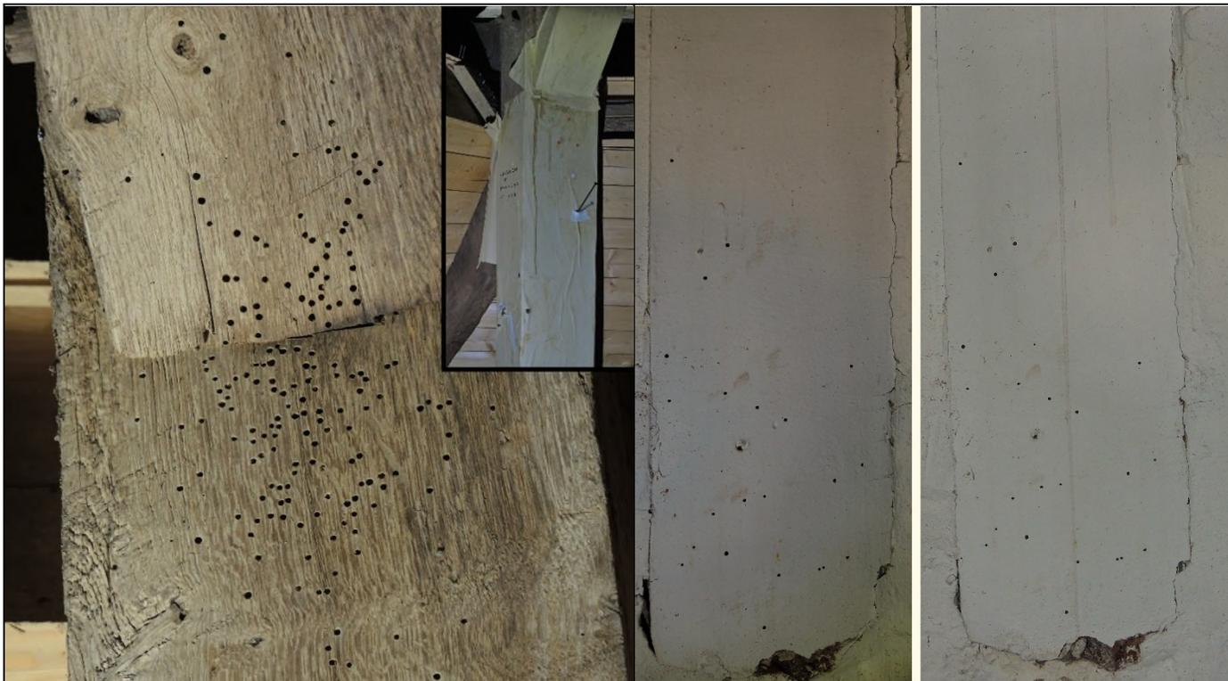
Abb. 73: Monitoring-Bereich: Turm, Anschluss an die Zwiebel; vor dem Bekleben; Eckbild: Abklebung; es wurden bewusst Bauteile mit Ausschluflöchern gewählt; Nachteil: die Daten können nicht 1 zu 1 auf das Bauwerk übertragen werden.
