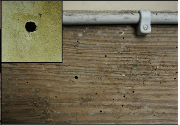
Abb. 18: Ausschluflöcher des Gewöhnlichen Nagekäfers (kleine Löcher) und des Gescheckten Nagekäfers (große Löcher) nebeneinander. Nur der Gescheckte Nagekäfer ist bei Eichenholz auf einen Pilzbefall angewiesen, zumindest als junge Larve. Ob das auch für das gezeigte Nadelholz gilt, ist unklar.
