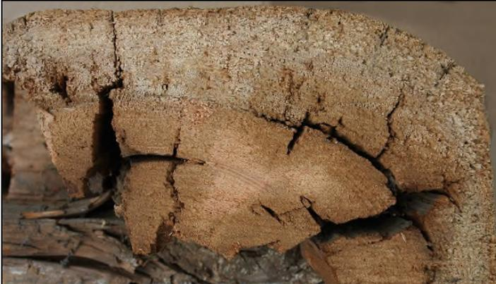
Abb. 44: Massive Innenfäule an einem Nadelholz-Balkenkopf durch den Gelben Porenschwamm/Braunfäuletramete (*Antrodia xantha*). Weißes Mycel durchzieht das Holz; der Würfelbruch ist auffällig groß und ohne Insekten-Schaden; Bildstreifen: Befallsverlauf unten: am Sparren unten nur Pilzbefall mit hellen Strängen, oben auch Ausschlußpflöcher.
