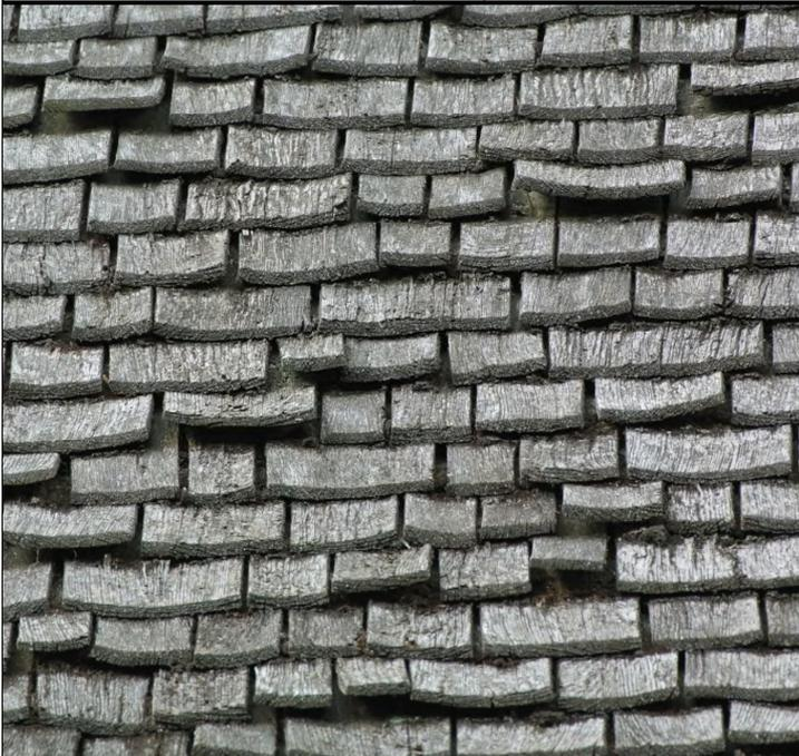
Abb. 33: Gespaltene Eichenholzschindeln, ca. 16 Jahre alt; Südseite (2016), eine Folienlage unter den Schindeln hat zusammen mit einer unzureichenden Unterlüftung zu der schnellen Alterung geführt.
