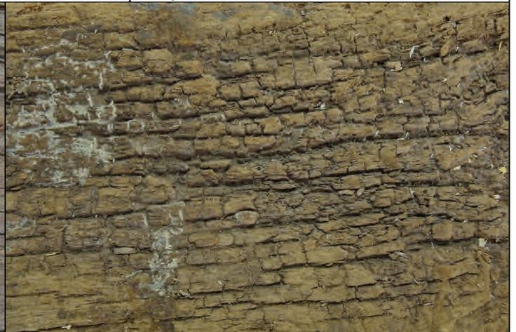
Abb. 11: Altes Querholz des Dachstuhls: derzeit nicht bewittert, trocken und vierseitig umlüftet; Eichenholz mit oberflächlichem Würfelfbruch durch Moderfäulepilze, aber nur wenige Schäden durch den Gescheckten Nagekäfer.
