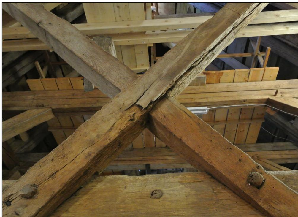
Abb. 37: Historisches Kreuz mit verschiedenen Schädigungen: Schäden durch den Gescheckten Nagekäfer und oberflächliche Moderfäulepilz-Schäden.
