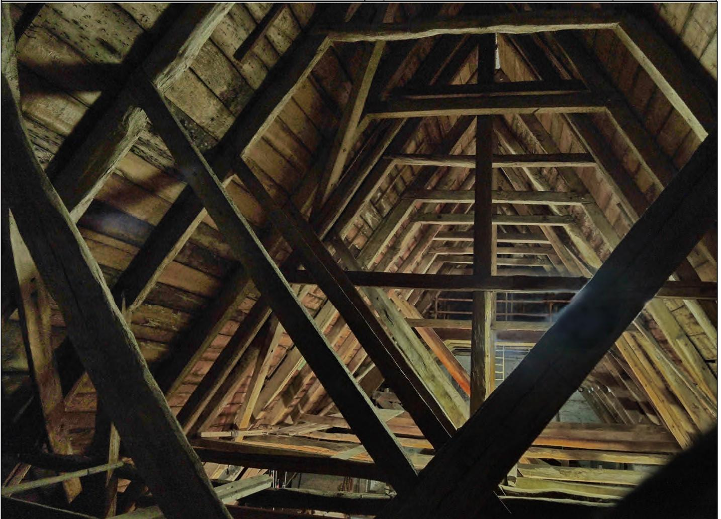
Abb. 31: Historischer Dachstuhl vor der Renovierung (2014). Das alte Tragwerk reicht statisch nicht mehr aus (das Dach senkte sich).
