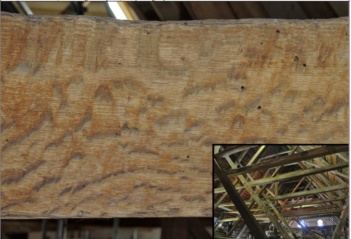
Abb. 8: Alte Dachstuhl-Strebe: altes Eichenholz mit Bearbeitungsspuren durch ein Breitbeil (bisher nicht bewittert); fast ohne Schäden durch den Gescheckten Nagekäfer; ein Befall ist von außen kaum sichtbar und das Holz nagelfest; Eckbild: Übersicht, Dachstuhl vor der Sanierung.
