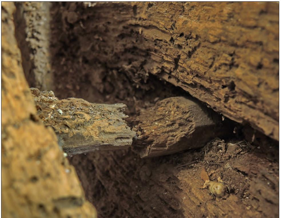
Abb. 78: Gebrochener Zapfen in einem Kreuz im Kirchen-Dachstuhl; durch den neu implementierten Dachstuhl im alten Dachstuhl konnten auch diese Teile erhalten werden
