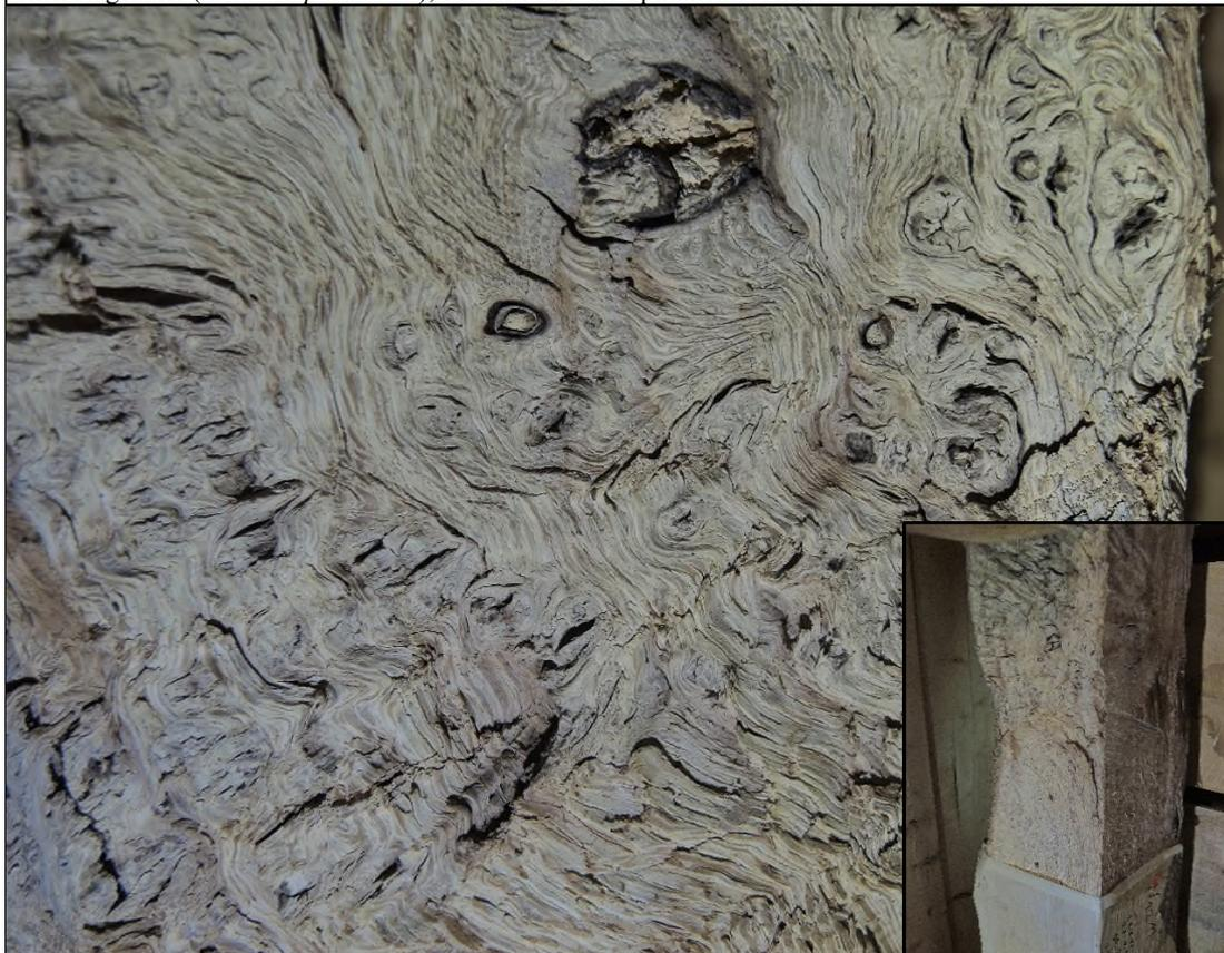
Abb. 69: Detail eines historischen Sparrens im Dachstuhl mit ungewöhnlichem Wuchsbild des Holzes – eine Maserknolle wurde am Balken verarbeitet; Eckbild: Einbausituation im Gebäude.
