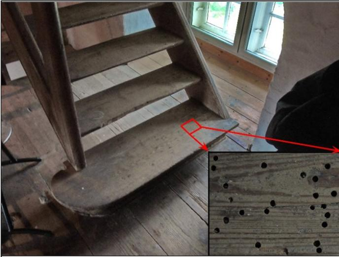
Abb. 17: Treppenaufgang mit einer Stufe aus Nadelholz, die einen Schaden durch den Gescheckten Nagekäfer aufweist. Eckbild: Detail der Ausschluflöcher.
