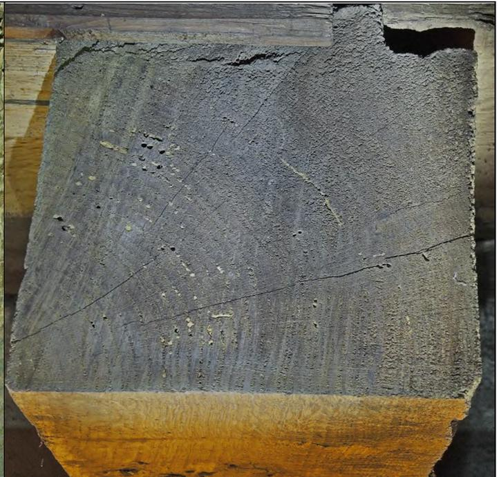
Abb. 48: Angeschnittene Fraßgänge belegen die Anwesenheit eines Schadens durch den Geseckten Nagekäfer vor 1955 (Detail aus Abb. 77). In diesem Jahre wurden die Glocken nach dem Krieg wieder aufgehängt. Die Fraßgänge folgen den Jahrringen und sind meist im Frühholz; und verstärkt im Splintholz (rechts).
