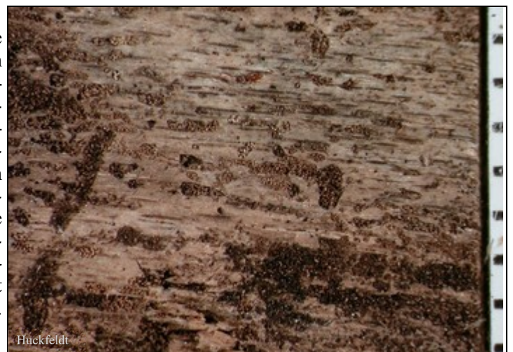
Abb. 8: Holz aus einem Badezimmer-Boden nach einem Tropfwasserschaden: Moderfäulepilze und Larven eines Rüsselkäfers haben das Holz stark angegriffen; Maßstab mit Millimetern
