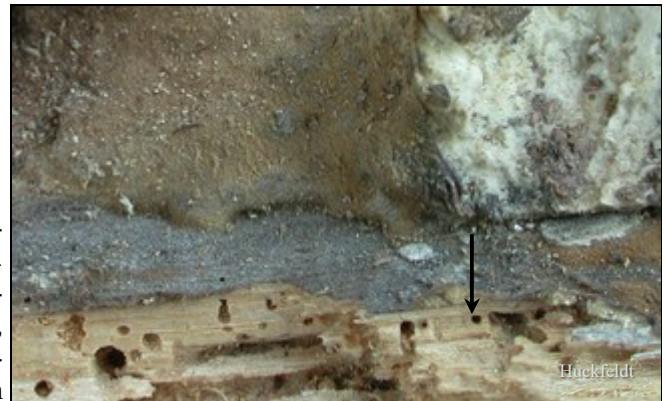
Abb. 2: Mycel des Ausgebreiteten Hausporlings auf einem insektengeschädigten Brett (↑) - Gescheckter Nagekäfer ( Xestobium rufovillosum )
