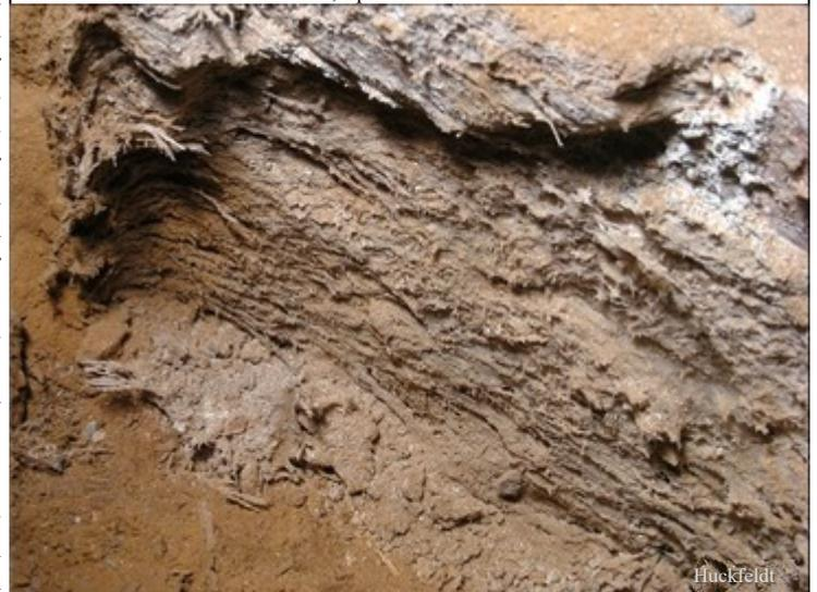
Abb. 8: Mycelbewuchs des Echten Hausschwamms (det. Huckfeldt) am/im Mauerwerk im Umfeld einer Balkenlage (mit intensiver Braunfäule); Holzteile zudem massiv durch Larven-Fraßgänge des Schwammholz-Nagekäfers (det: Dr. Noldt) geschädigt.
